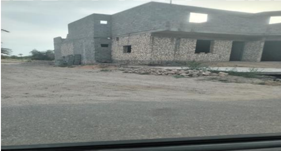
صورة (٤) بناء هياكل المساكن في المشتل
